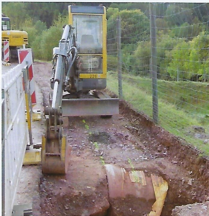
Straßenarbeiten am Weierfeld
