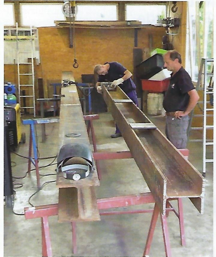
Arbeiten an der neuen Brücke
